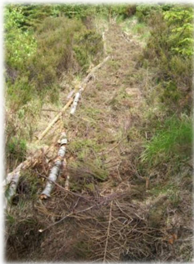
Nu zijn ook de gewone balken op en wordt het pad bedekt met kreupelhout
